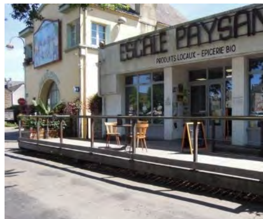
^ Exemple garde-corps transparent en totalité. Ce plancher permet un bon écoulement des eaux pluviales en dessous
