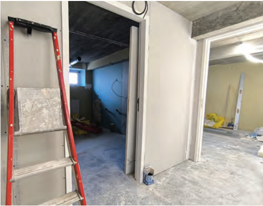
Au sous-sol, l'espace est entièrement repensé et optimisé : zones de stockage, vestiaires équipés d'une douche réglementaire, ainsi qu'une pièce dédiée aux déchets et au tri. L'ensemble est cloisonné selon les usages.
