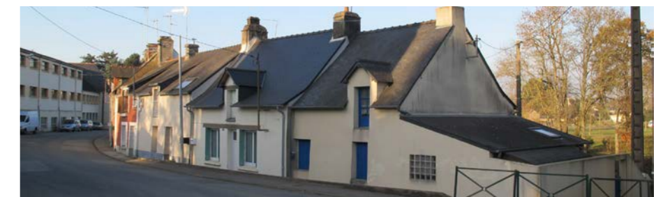
Le faubourg Saint Julien - alignement sur rue
