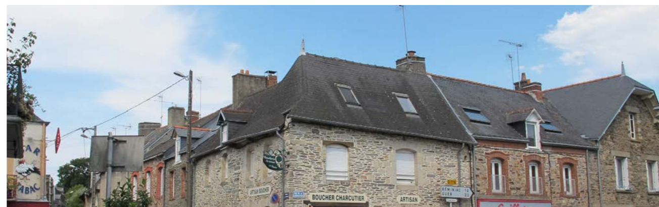
Les couvertures d'ardoises des toitures de Malestroit
