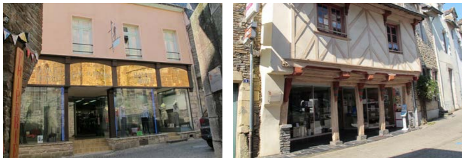
Devantures commerciales de la rue du Général de Gaulle, transformées dans la deuxième moitié du XX e , située en retrait de façade, privilégiant la voiture.
