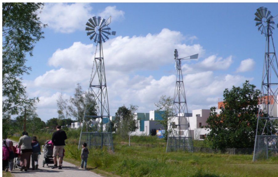
Eoliennes de la Bottière-Chenaie - Nantes L'énergie éolienne permet de renouveler un apport en eau d'arrosage vers les jardins partagés et le parc.
