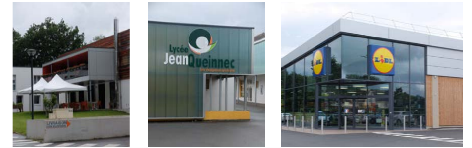
Constructions récentes à Malestroit
