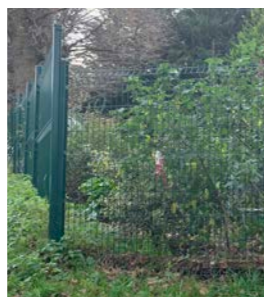
Grillage industriel sans accompagnement végétal
