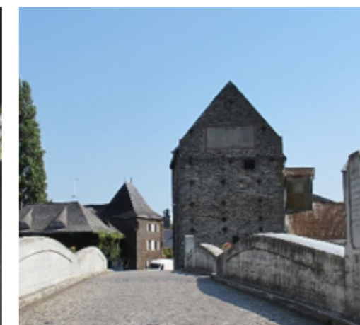
L'ancienne minoterie. Photo © ASP
