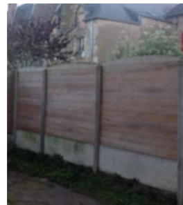
Enduit ciment et panneaux claustra préfabriqués
