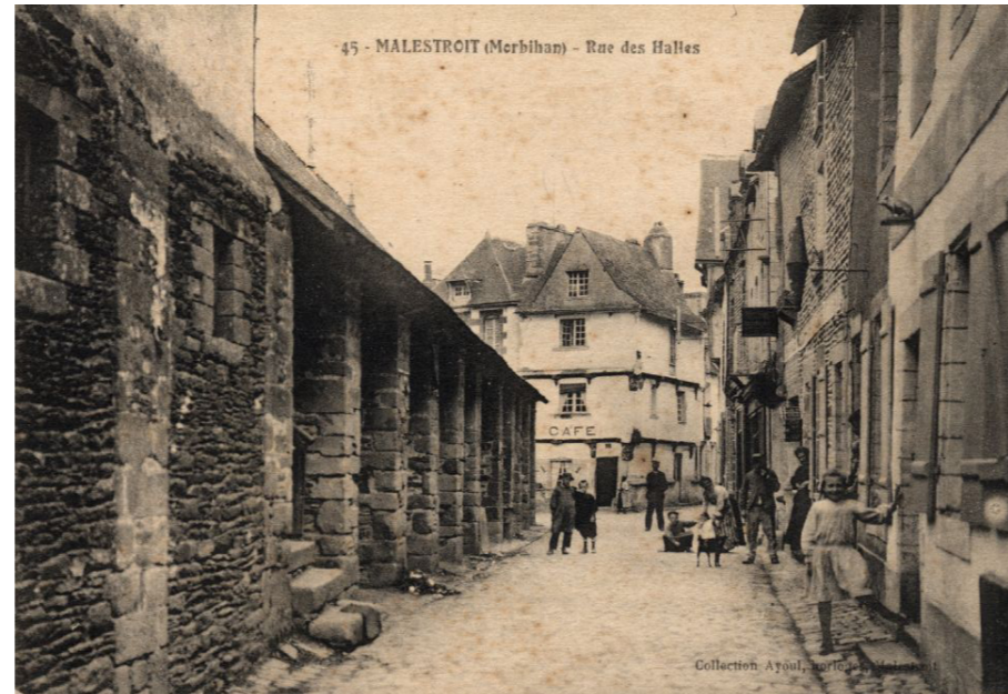
Rue des Halles au début du XXe siècle (les halles sont à gauche)
