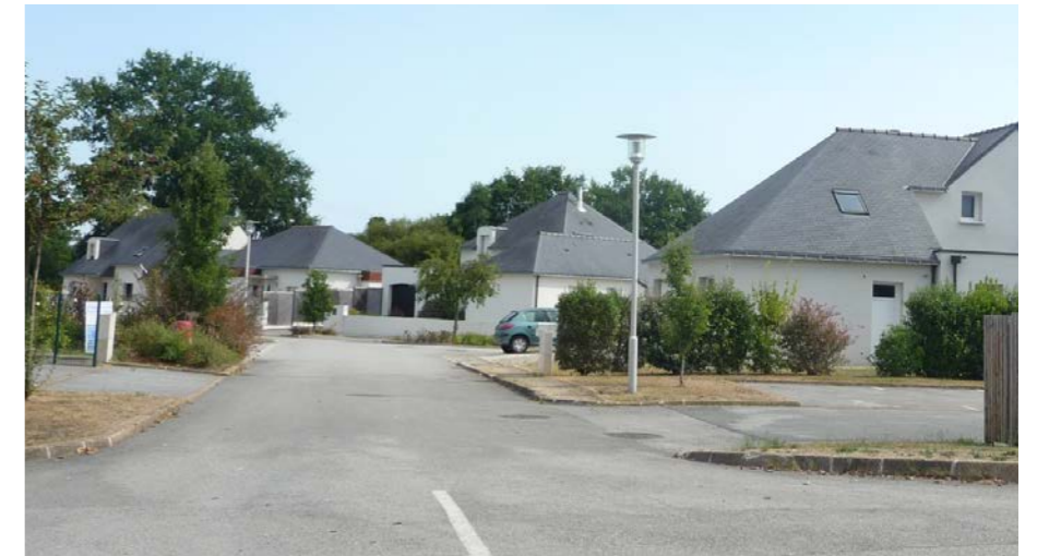
④ Lotissements à l'Est du Faubourg de la Madeleine. Photos © ASP
