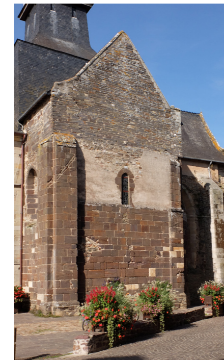
Transept sud de l'église Saint-Gilles
