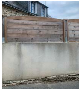
Enduit ciment et panneaux claustra préfabriqués
