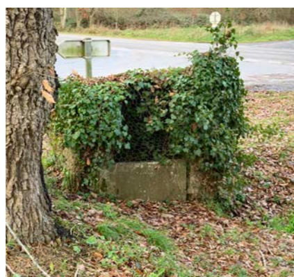
Puits, route de Sérent
