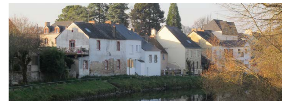
Le faubourg Saint Julien - arrières donnant sur le canal
