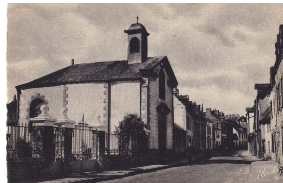
La chapelle Sainte Anne dans la perspective du faubourg Saint-Anne, après démolition des constructions de l'hôpital sur rue
