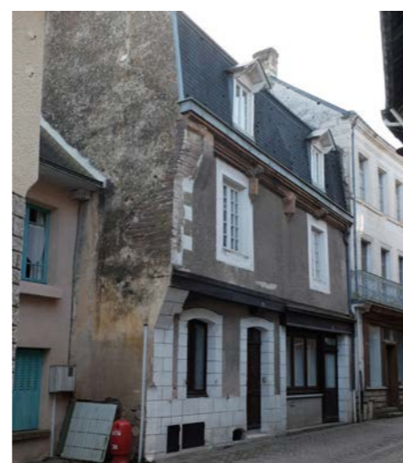
Pans de bois enduits rue des Ponts
